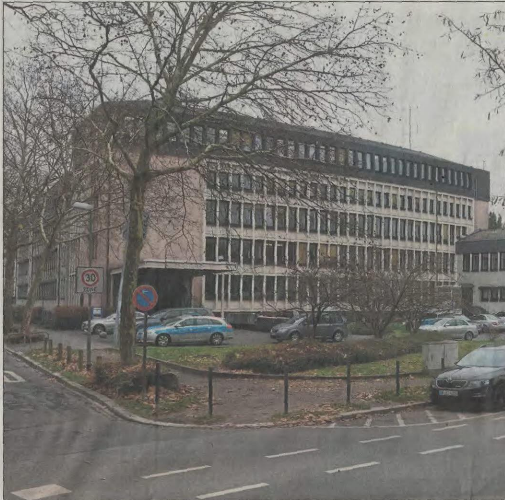
Das Gebäude an der Geleitsstraße weicht nach dem Umzug des Polizeipräsidiums dem Schul-Neubau.
