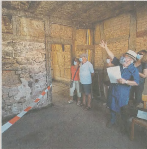
Fachwerkhaus-Sanierung an der Aschaffenburger Straße
