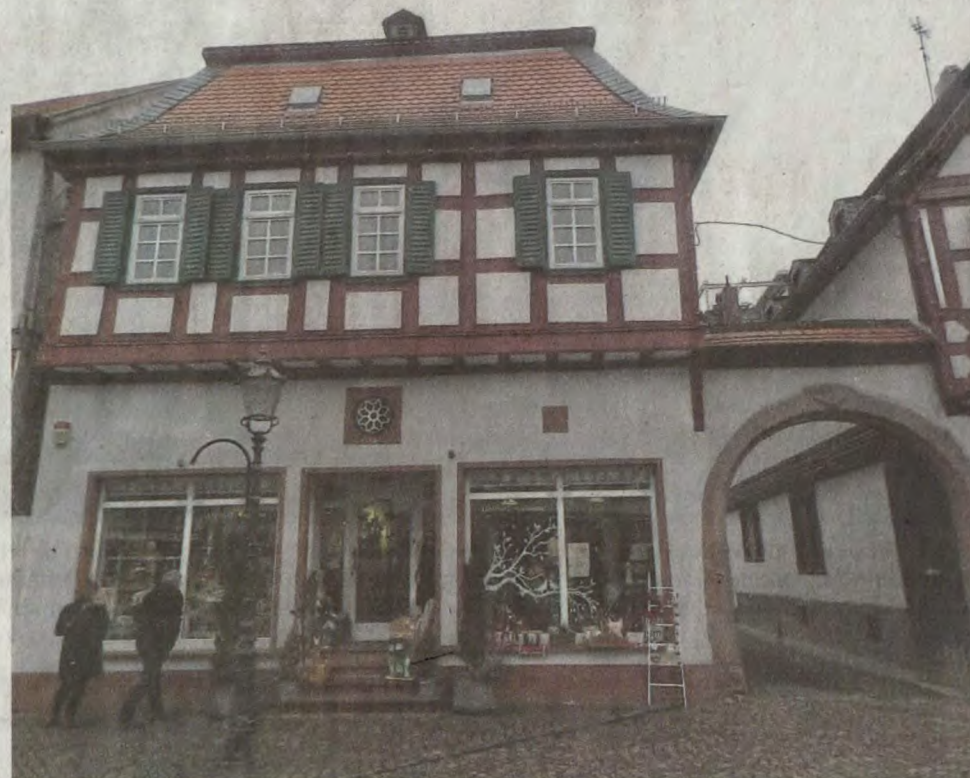
Das „Haus zum Stern“ soll das Geburtshaus des Künstlers sein. Dort soll der Gedenkstein angebracht werden – wenn die Denkmalschutzbehörde das genehmigt.
